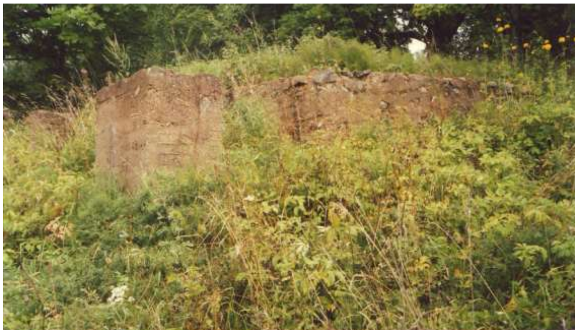
Ludwikowo - fundamenty starego kościoła
